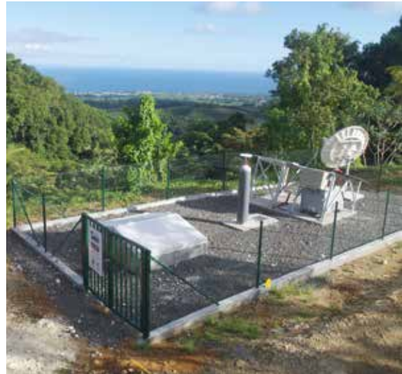
Station sismologique et géodésique de l'OVSG/IPGP à Capesterre-Belle-Eau – Guadeloupe © IPGP
